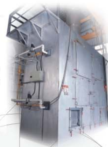
全響室迴風消音器 Silencer in Exhaust Duct
